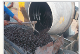
Cold mix production
