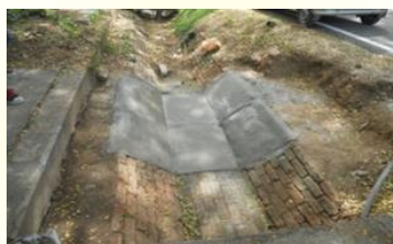
टेक्सटाइल प्रबलित कंक्रीट को उपयोग से कैनल लाइनिंग
