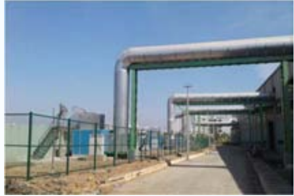
चित्र:7.8 केसीडीसी, बेंगलूर में 500tdp MSW यांत्रिक जैविक उपचार संयंत्र में गंध नियंत्रण प्रणाली। संयंत्र (दायीं ओर) से बायोफिल्टर्स (बायीं ओर) तक नलिका का निकास।
