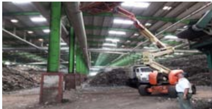
चित्र:7.9 500tdp नगरपालिका ठोस अपशिष्ट उपचार सुविधा में निर्माणाधीन गैस बायोफिल्टर। निकास नलिका का अधिष्ठापन
