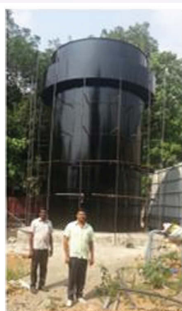
BFBR under construction for rice-mill effluent. Licensee: Galaxy Environ. Pvt. Ltd.
